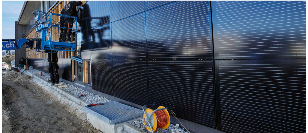
Installation der PV Anlage an der Fassade
