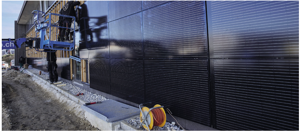
Installation der PV Anlage an der Fassade
